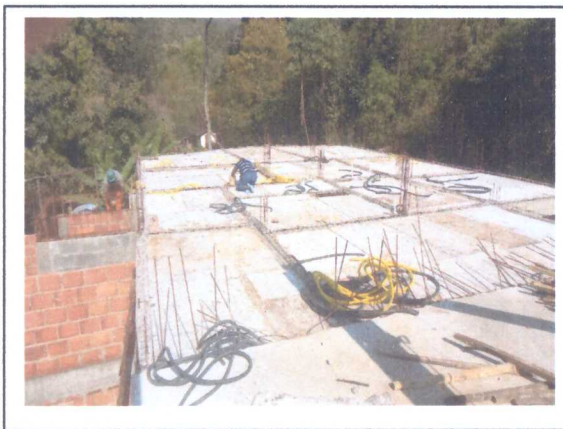
MONTAGEM DA LAJE
