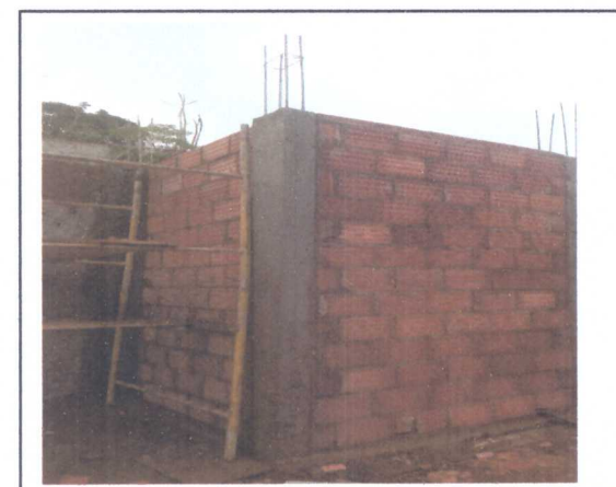
ALVENARIA E ESTRUTURA
