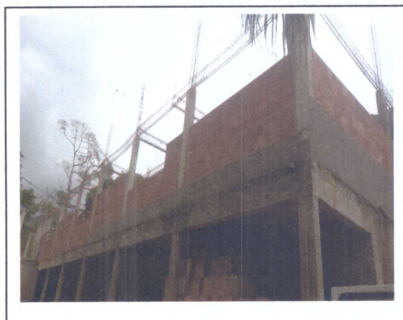
ALVENARIA E ESTRUTURA
