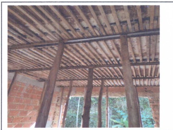
ESCORAMENTO DA LAJE
